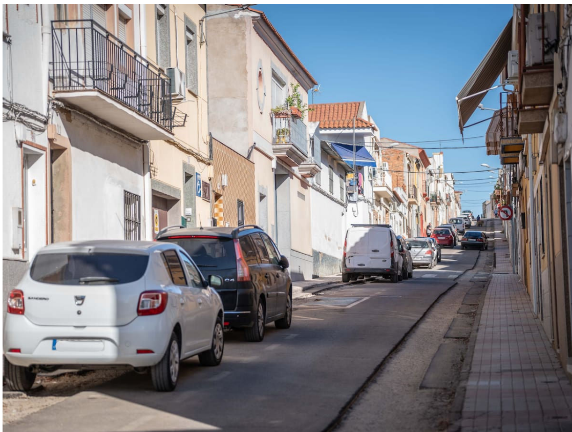
Obras de mejoras hidráulicas en San Juan / Ayuntamiento de Mérida
